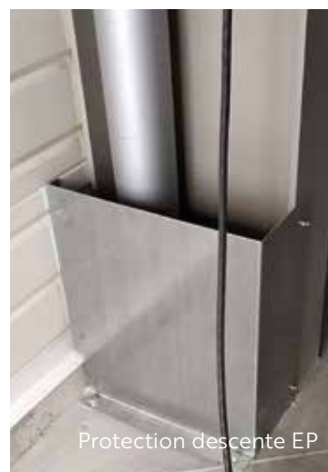
Protection descente EP avec capotage
