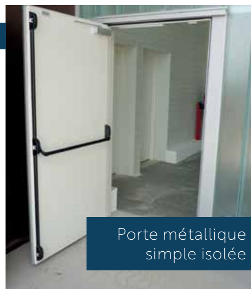
Portes métalliques local transformateur
