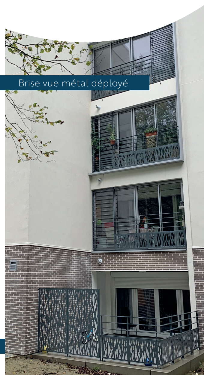
Barreaudage de fenêtre
